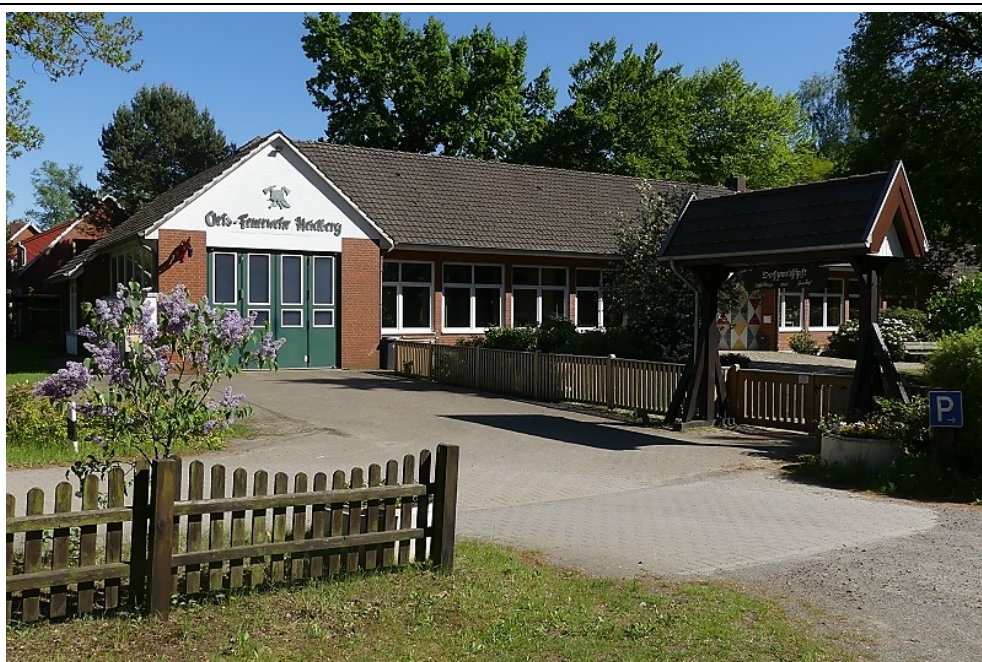
Abb. 1: Vorderer Bereich Dorfgemeinschaftshaus und Feuerwehr
