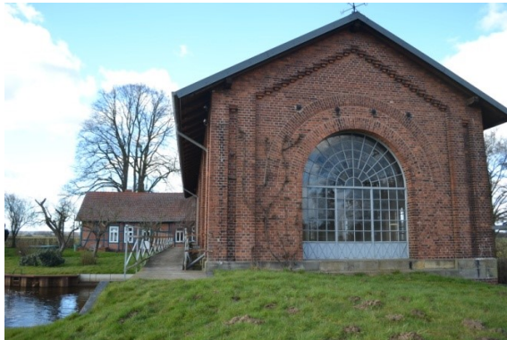
Schöpfwerk an der Wümme in St. Jürgen
