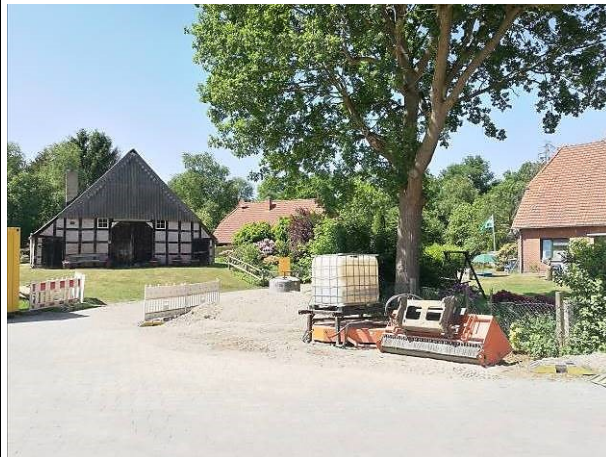
Abb. 4. Die Kreuzung Heinrich-Schmidt-Barrien-Weg/Auf der Frankenburg (erhält gerade eine neue Pflasterung).
